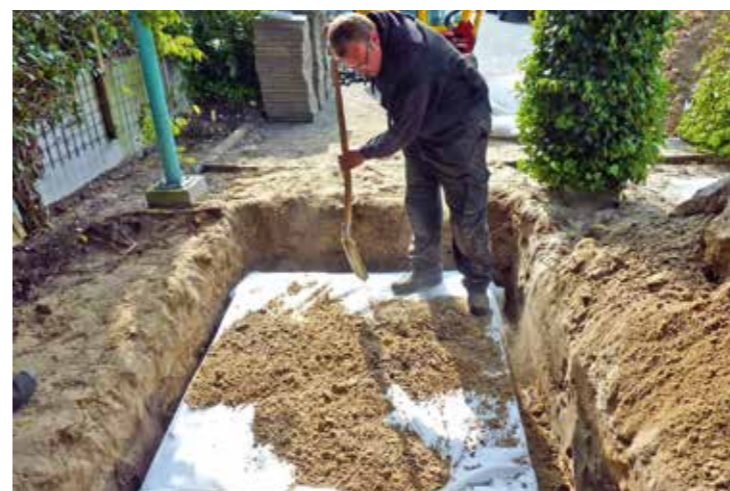
Het ingraven van de infiltratiekratten onder de bestrating van de oprit. Ter plekke zijn de kratten met geotextiel omwikkeld. Onder de kratten en eromheen komt grof zand zodat de kratten stevig te plaatsen zijn, bovenop een laag voor de bestrating.
