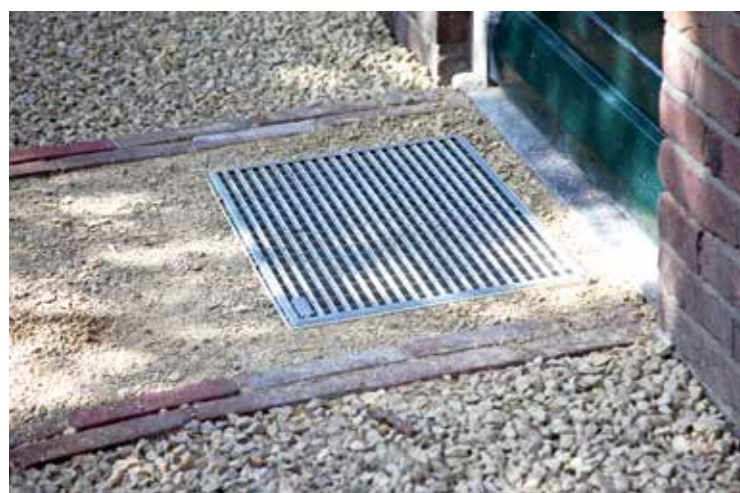
Het tuinpad heeft een halfverharding van Gravidux gekregen. Bij de voordeur is voor schone voeten een rooster in de halfverharding geplaatst. Foto geheel boven: De beplanting bestaat uit een mix van vaste planten, waarbij goed is gekeken naar de vochtigheid. Er groeit onder meer Geum rivale , Hemerocallis lilioasphodelus , Liriope muscari 'MoneyMaker' en Brunnera macrophylla 'Jack Frost'.
